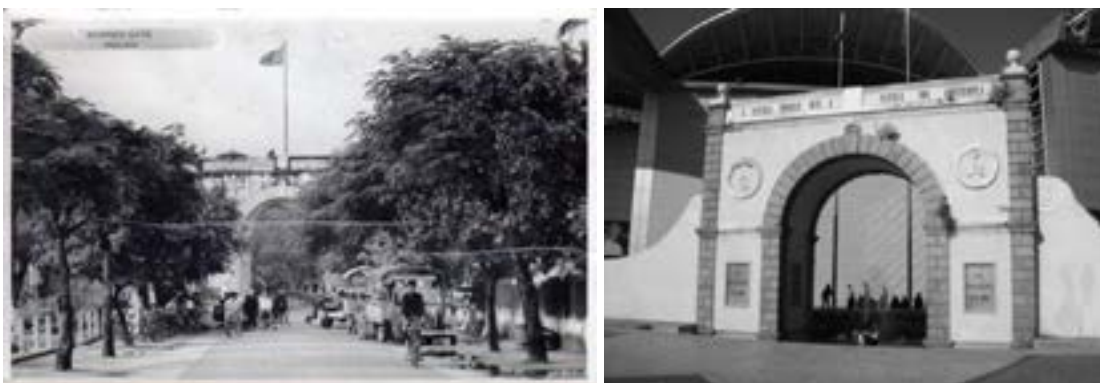
Ilustração 14- Posto fronteiriço das Portas do Cerco. Em cima, as Portas do Cerco nos anos 50 (Botas, 2013); em baixo, as Portas do Cerco nos dias de hoje com o novo edifício de controlo fronteiriço atrás. (Beitler, 2018).
