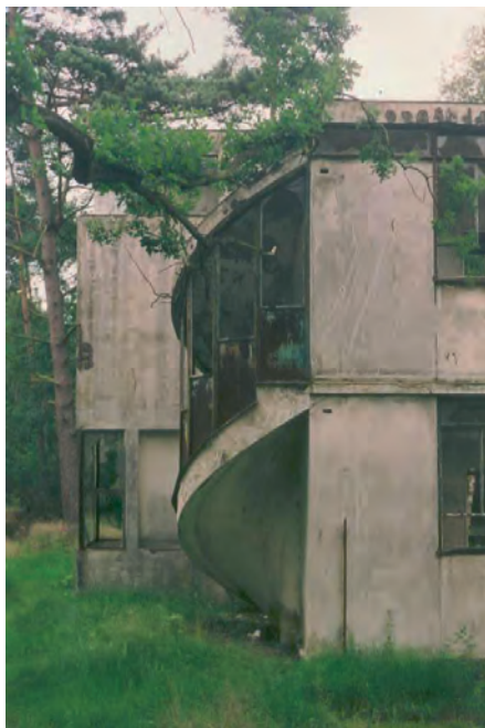
Figura 7 - Sanatório de Zonnerstraal em abandono, s/d.
