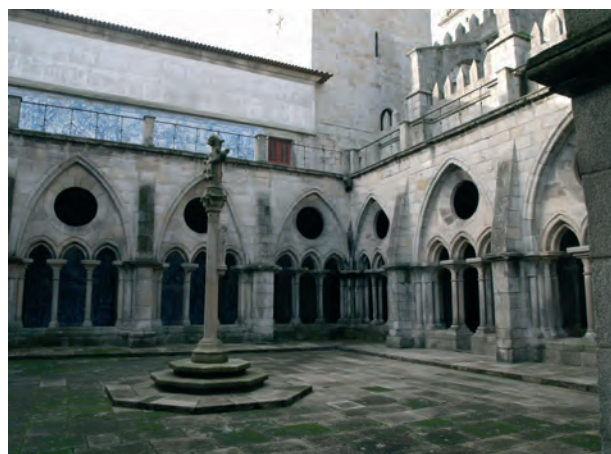
Fig. 7 - Claustro da Sé do Porto, onde se notam as características da arquitectura cistercense.
