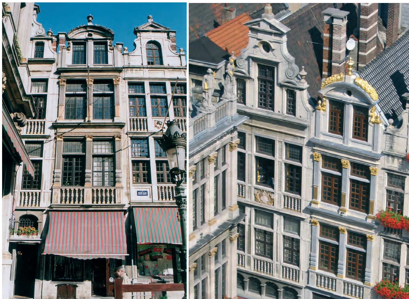
Figure 2: Maison « L'Ane » avant et après restauration, 1999, 2004
