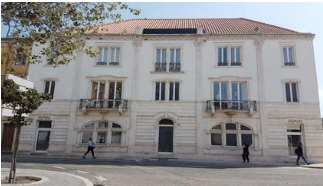
Ilustração 51 - Comparação entre a fachada atual (Ilustração nossa, 2017)
