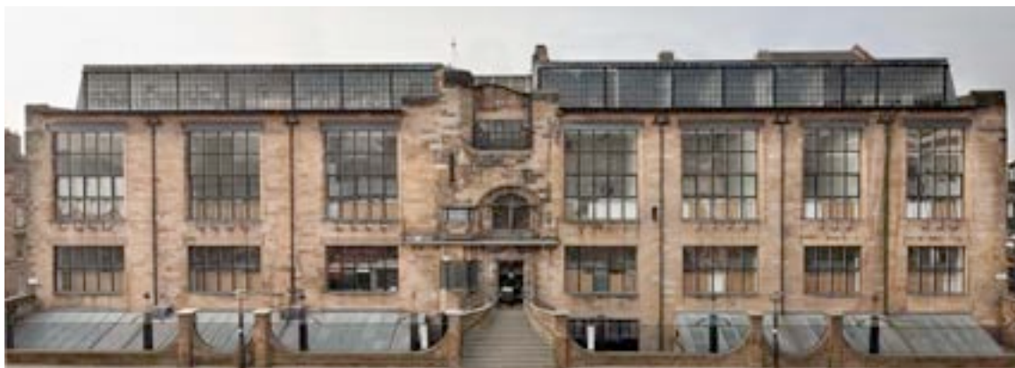
Ilustração 3 - Escola de Belas-Artes de Glasgow: fachada principal, Alan McAteer. (Basulto, 2017).
