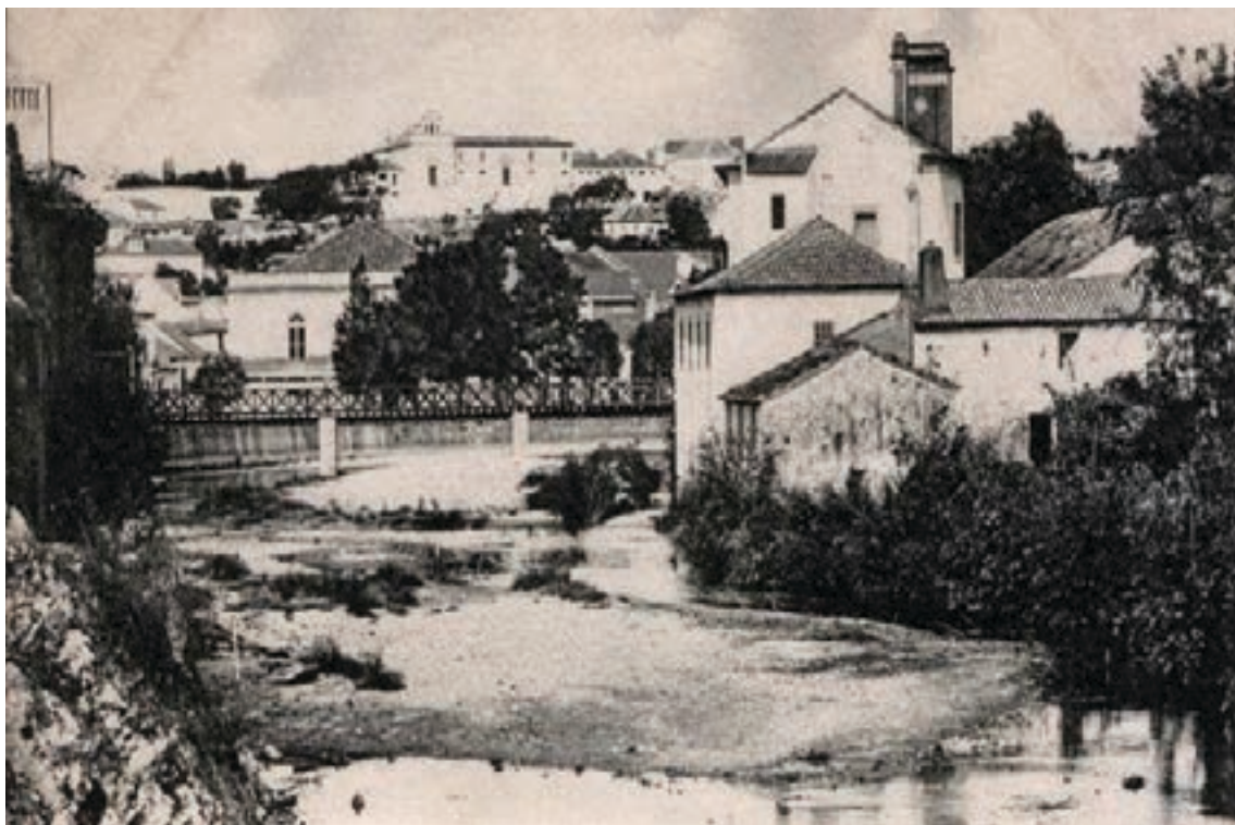
Ilustração 24 - Ponte de Madeira que substituiu temporariamente a ponte dos Três Arcos, espinha dorsal da cidade de Leiria. (Cordeiro, s.d., imagem 20)
