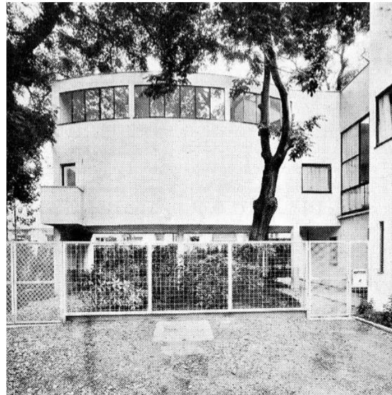
Ilustração 42 - Villa La Roche, A zona de chegada (Le Corbusier, 1995, p. 67)
