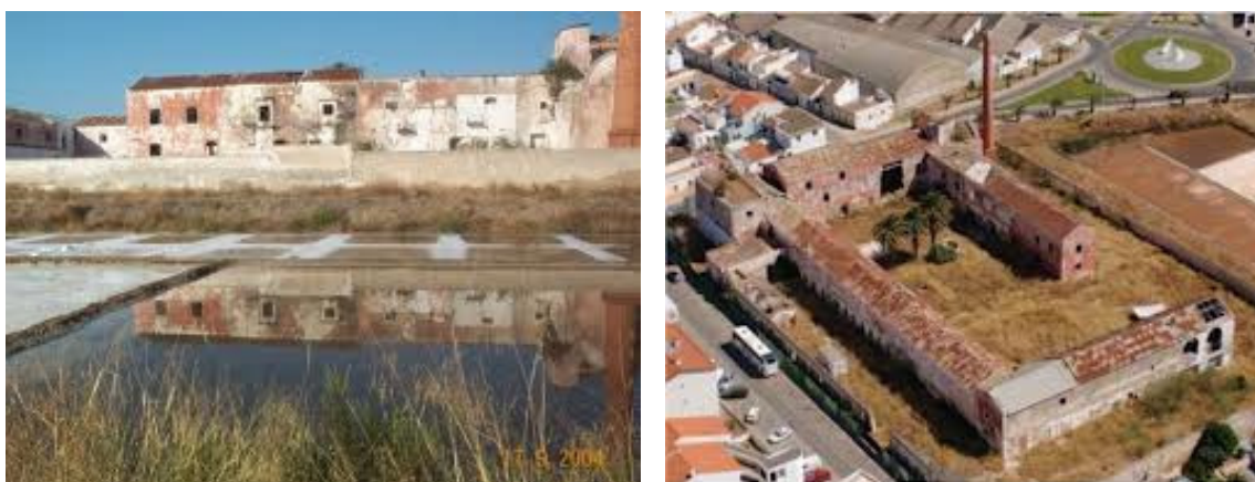
Ilustração 30 - Imagens do Convento das Bernardas em Tavira, que evidenciam o avançado estado de degradação em que se encontrava o edifício, antes das obras de reabilitação. (Convento das Bernardas)
