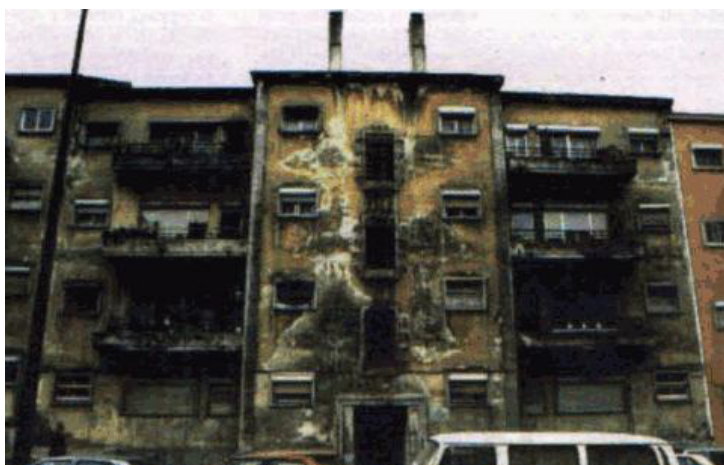
Ilustração 22 - Exemplo de edifício com envolvente degradada, demonstrando anomalias decorrentes de problemas de estanquicidade. Porto. (Ilustração nossa)
