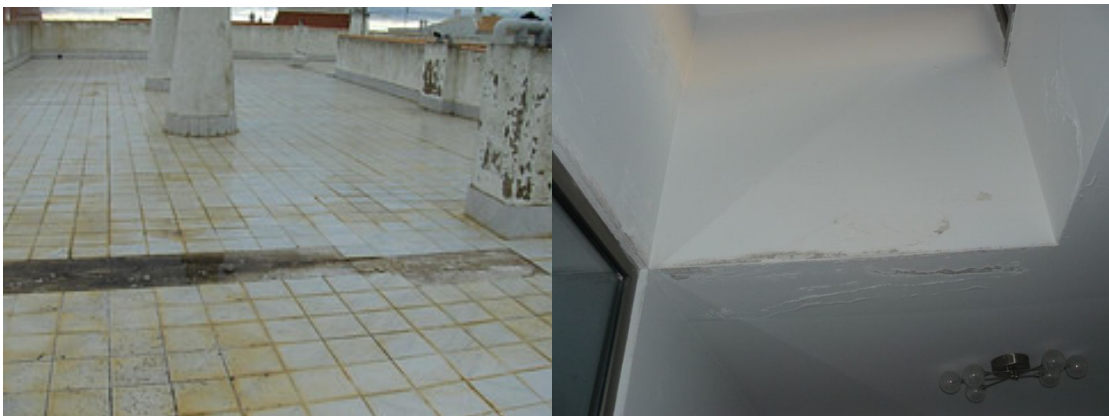
Ilustração 24 - Exemplo de patologia em cobertura plana decorrente de má estanquicidade. (Ilustração nossa)
