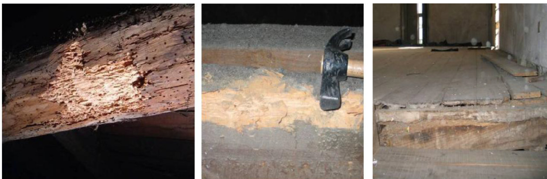
Ilustração 27 - Presença de ataques de insectos xilófagos (lados esquerdo e centro) e deformação do pavimento devido a ataque de térmitas (lado direito). (Ilustração nossa)
