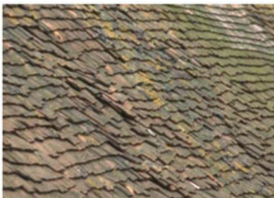
Ilustração 23 - Exemplo de patologia em cobertura inclinada por deslocamento das telhas (Ilustração nossa)
