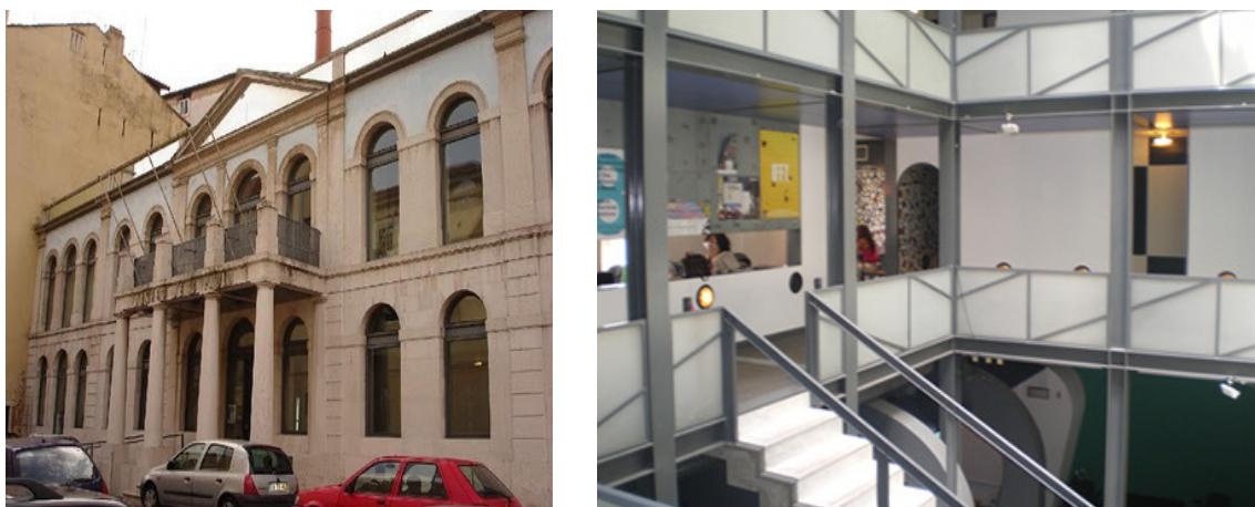
Ilustração 28 - Intervenção Fachadista no edifício dos antigos Banhos de São Paulo em Lisboa, actual sede da Ordem dos Arquitectos. Arquitecto Graça Dias. A fachada do edifício manteve-se (à esquerda); o seu interior foi totalmente alterado (à direita). (Ilustração nossa)
