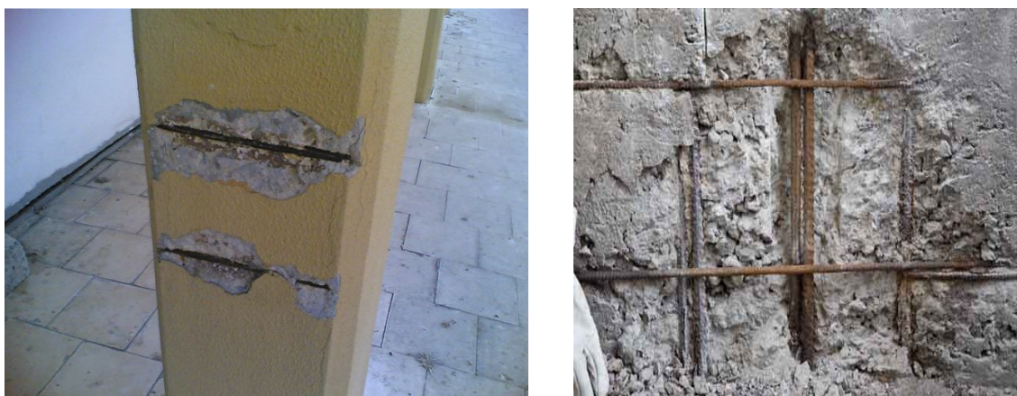
Ilustração 21 - Exemplo de caso típico de pilar com descasque do betão em torno de armaduras oxidadas (Ilustração nossa)
