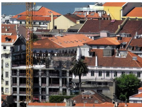
Ilustração 1 – Exemplo de Intervenção após demolição. (Ilustração nossa, 2009)
