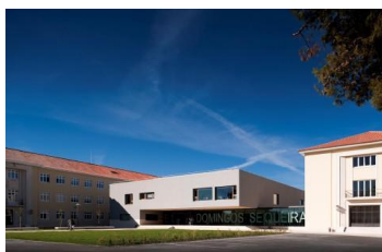
Ilustração 11 – Fachada principal da Escola Secundária Domingos Sequeira
