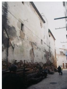
Ilustração 19 – Fachada Norte do Convento das Bernardas
