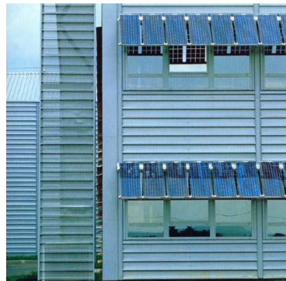
Imagem 61: Escritórios e oficinas da Total Energie em Tour de Salvagny, do arquitecto Jacques Ferrier
