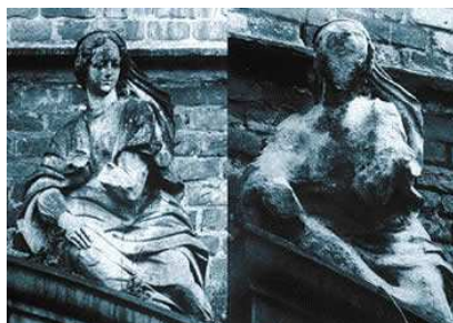
Imagem 54: O efeito da chuva ácida nos monumentos. Com o tempo, os ácidos corroem os materiais, deteriorando-os
