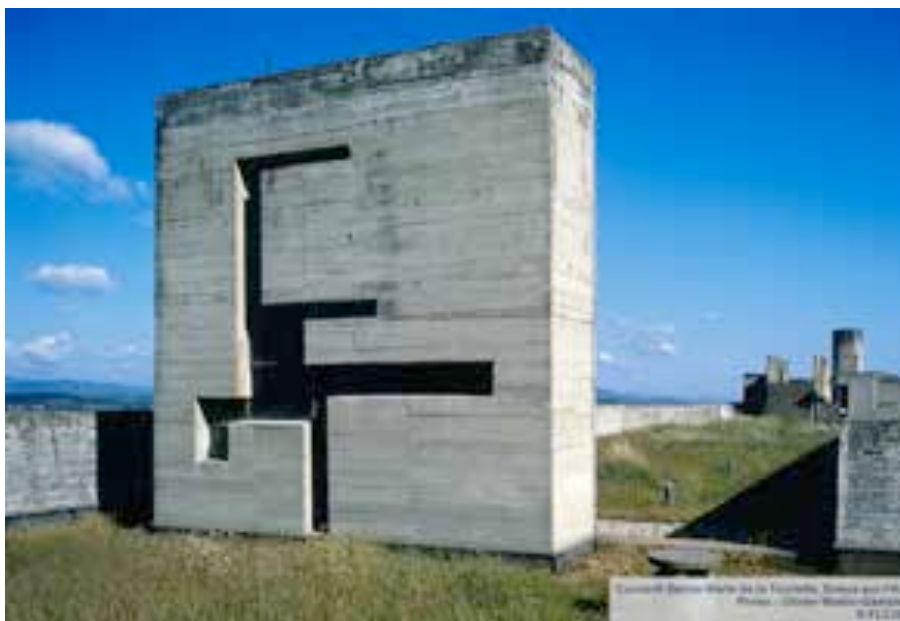
Ilustração 6 - Abertura ao céu: monólito e muro de delimitação na cobertura do convento de Santa Maria de La Tourette, Oliver Martin Gambier, 2004 (Fondation Le Corbusier, 2012)
