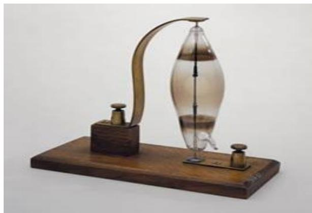
Ilustração 53 – A lâmpada de arco voltaico. (LADR, 2011)
