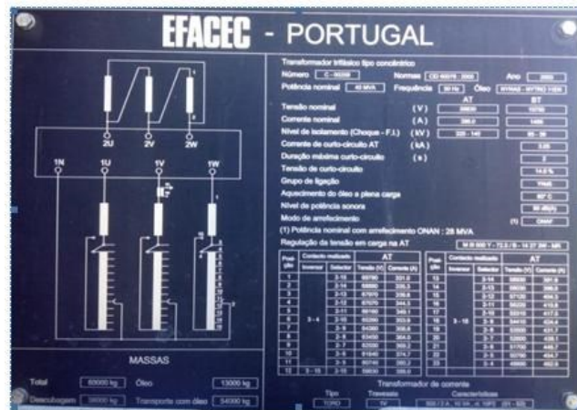
Figura 47: Chapa de características para comparação de resultados [EDP].
