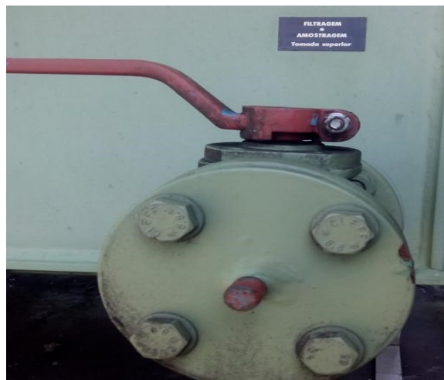
Figura 36: Válvula para amostra e filtração do óleo SE Custóias [EDP].
