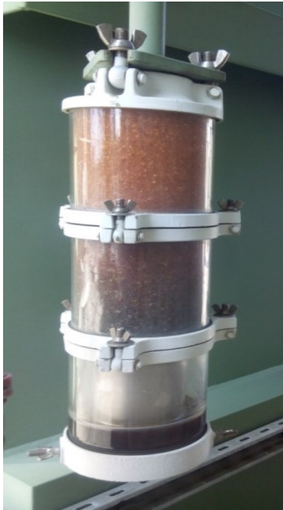
Figura 17: Exsicador de ar do depósito expansão [SE EDP].
