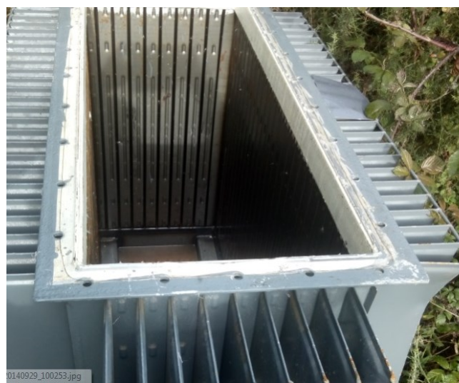
Figura 13: Cuba de um transformador 630 kVA [EDP].
