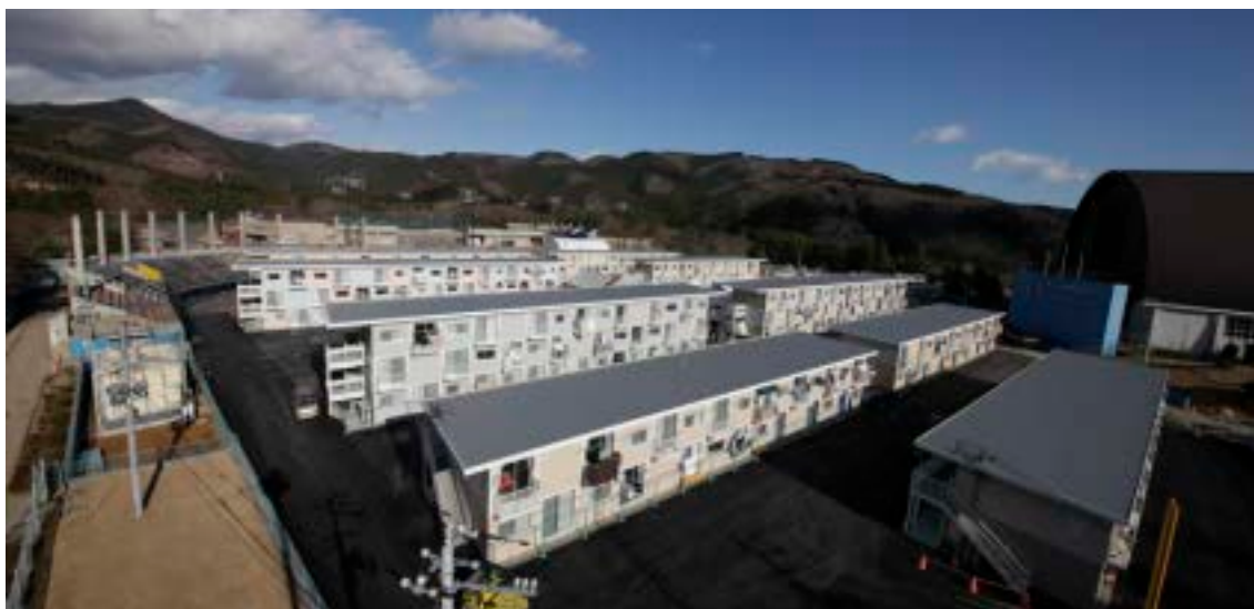
Ilustração 32 – Onagawa Container Temporary Housing de Shigeru Ban, no Japão. Fotografia de Hiroyuki Hirai. ([Adaptada a partir de:] Shigeru Ban Architects, 2016).
