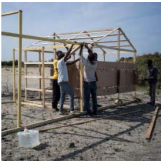
Ilustração 48 – Montagem do Sistema modular de abrigo, fotografia de Olivier Laban-Mattei. ([Adaptada a partir de:] Laban-Mattei, 2015).
