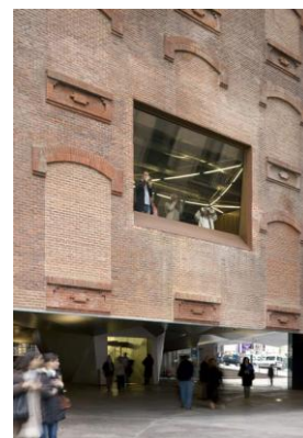
Ilustração 75 – Vista do novo vão.
