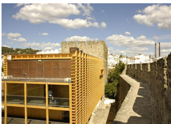
Ilustração 17 – Intervenção no Castelo de Portalegre, (Cândido Chuva Gomes, 2006).
