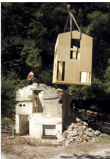
Ilustração 8 – Imagem do projecto em construção.
