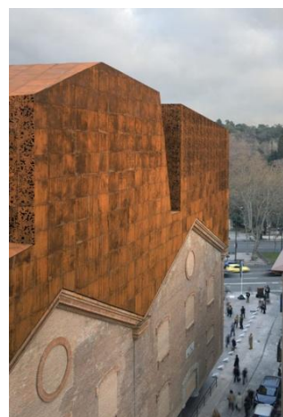
Ilustração 61 – Vista da CaixaFórum.
