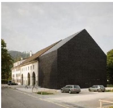
Ilustração 25 – Extensão da Wettlingen School, Suíça (MLZD architekten, 2008).
