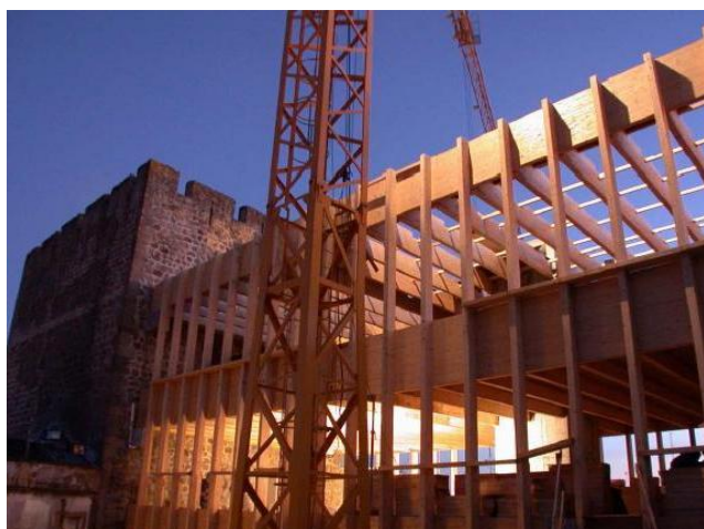
Ilustração 43 – Corpo principal da proposta em construção.
