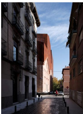
Ilustração 73 – Vista da Calle de la Alameda.
