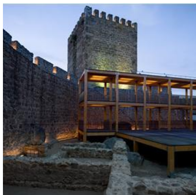
Ilustração 53 – Galerias no pátio do Castelo.
