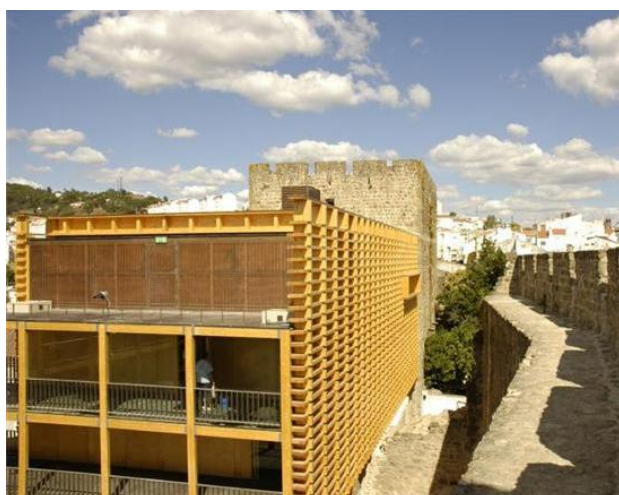
Ilustração 45 – Vista lateral do novo elemento arquitectónico.
