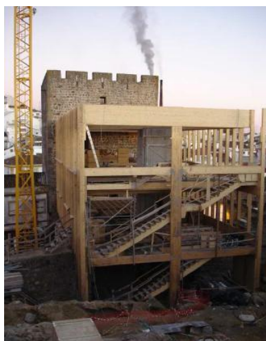
Ilustração 41 – Corpo principal da proposta em construção.
