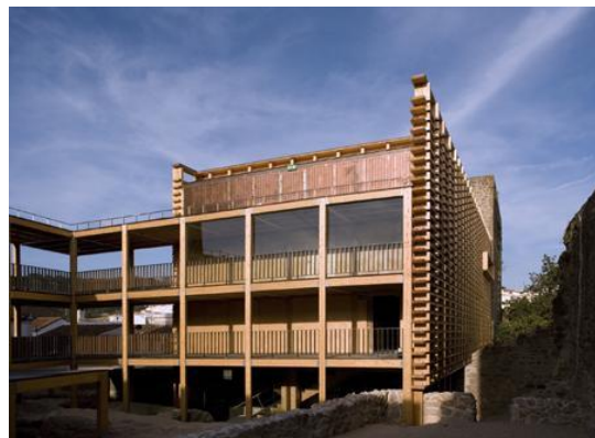
Ilustração 54 – Vista das galerias no pátio do Castelo.
