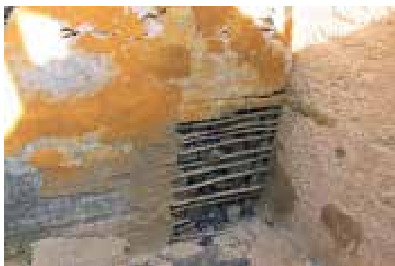
Ilustração 141 – Pormenor da parede divisória – tabique. (Ilustração nossa, 2016).
