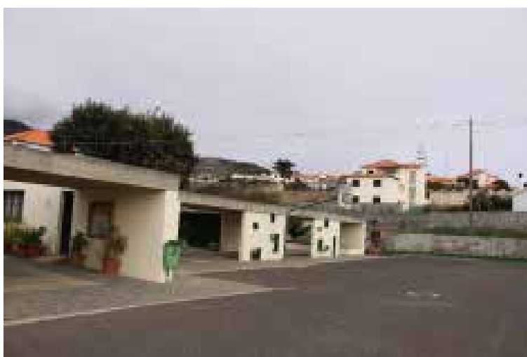
Ilustração 266 – Fachada Sul da Escola Primária do Porto Santo. (Ilustração nossa, 2016).
