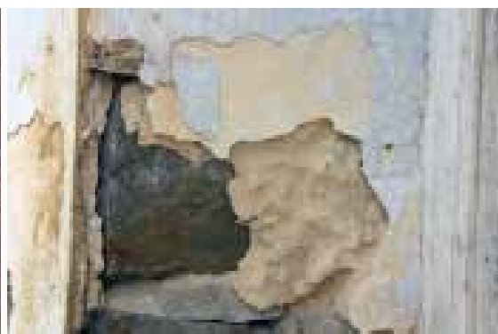
Ilustração 130 – Acabamento interior das paredes exteriores da casa de salão. (Ilustração nossa, 2016).
