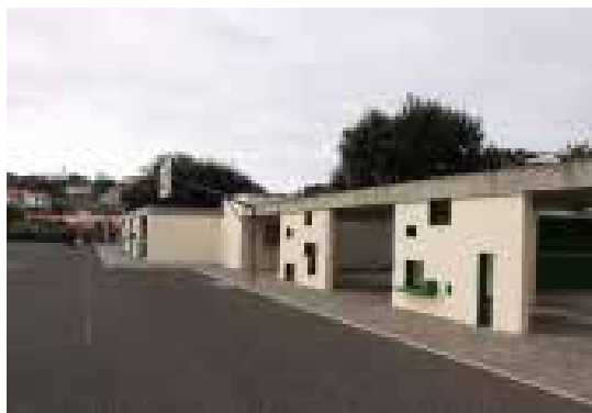
Ilustração 236 – Fachada Sul da Escola Primária do Porto Santo. (Ilustração nossa, 2016).
