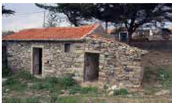
Ilustração 55 – Casa de salão com cobertura de telha. (Ilustração nossa, 2016).
