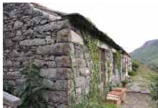
Ilustração 244 – Pormenor da parede (Ilustração nossa, 2016).
