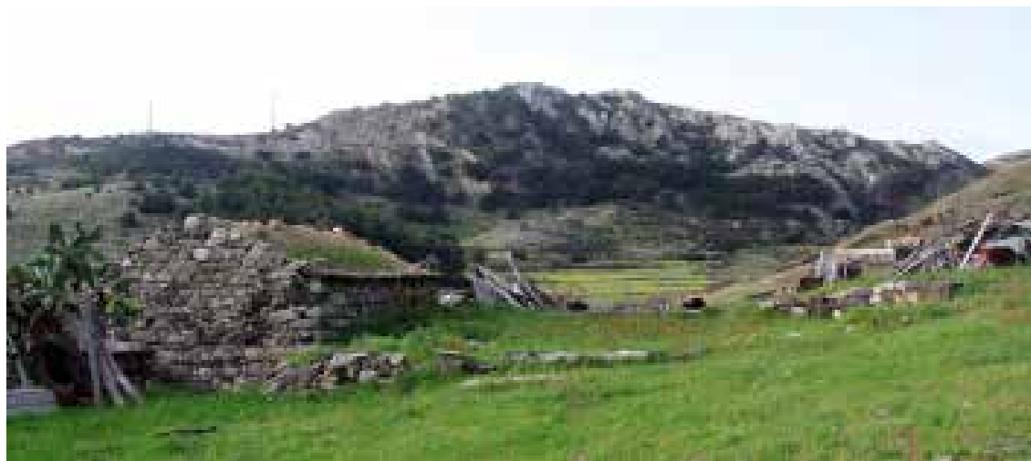
Ilustração 202 – Vista Este da edificação do palheiro e estábulo do caso de estudo 5. (Ilustração nossa, 2016).
