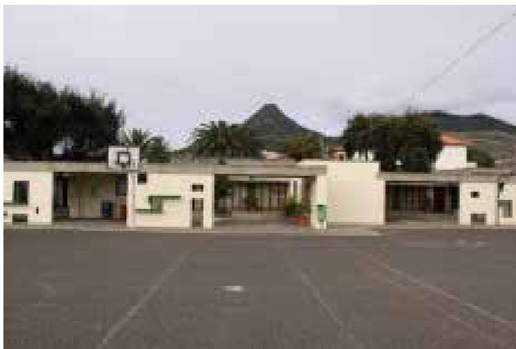
Ilustração 265 – Fachada Sul da Escola Primária do Porto Santo. (Ilustração nossa, 2016).
