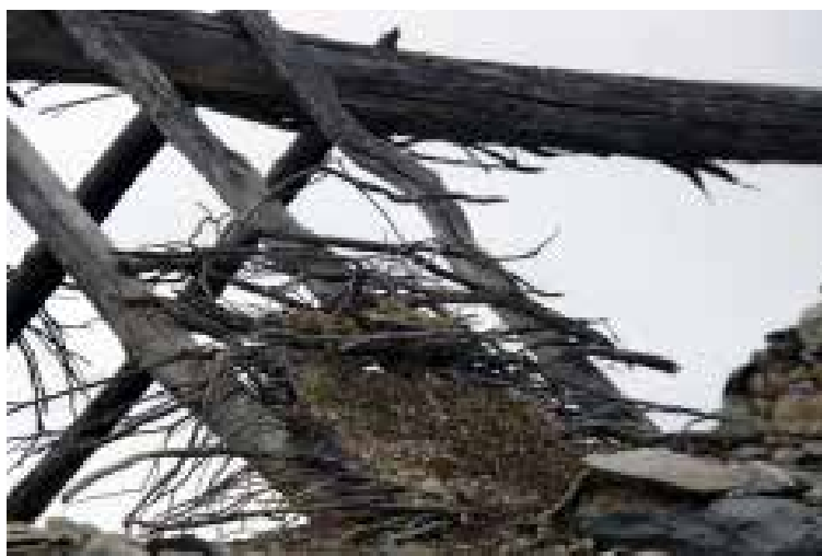
Ilustração 112 – Cobertura de salão da edificação com palheiro e estábulo. (Ilustração nossa, 2016).
