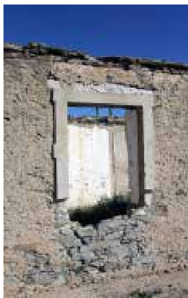
Ilustração 168 – Ombreiras da janela de peito. (Ilustração nossa, 2016).
