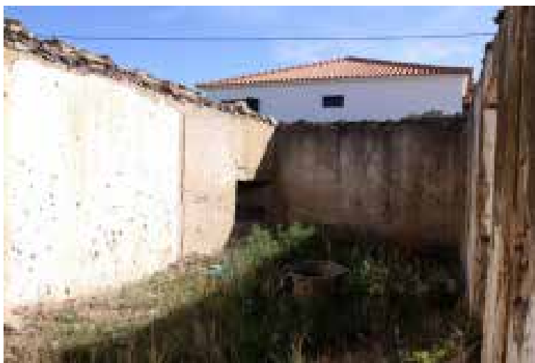
Ilustração 171 – Vista interior da fachada Norte e Este da habitação. (Ilustração nossa, 2016).
