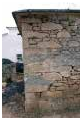
Ilustração 47 – Pormenor da parede exterior. (Ilustração nossa, 2016).
