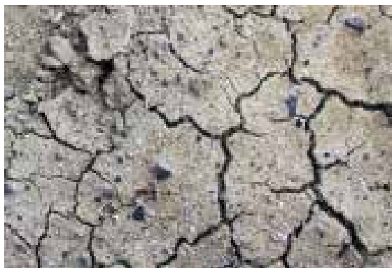
Ilustração 79 – Salão fendilhado. (Ilustração nossa, 2016).
