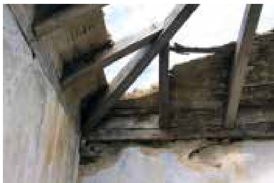
Ilustração 135 – Pormenor da ripagem e armação dos caibros no rincão da cobertura de salão. (Ilustração nossa, 2016).
