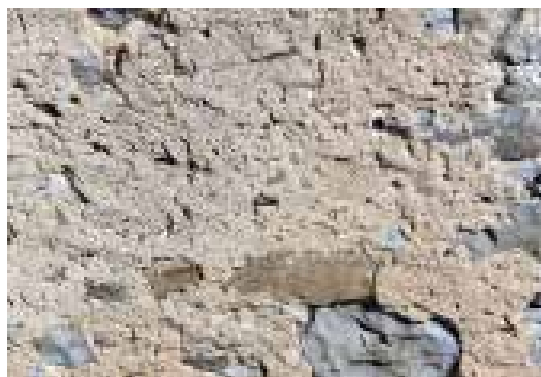
Ilustração 166 – Parede exterior da habitação. (Ilustração nossa, 2016).
