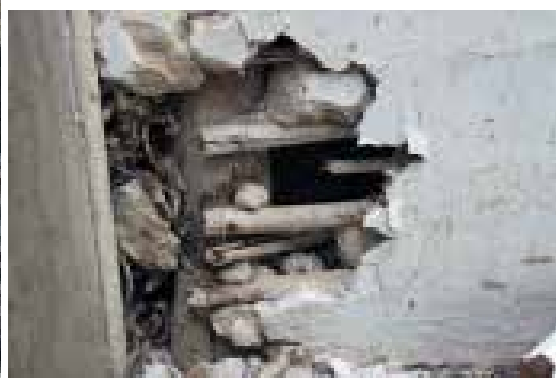
Ilustração 66 – Pormenor da parede divisória. (Ilustração nossa, 2016).
