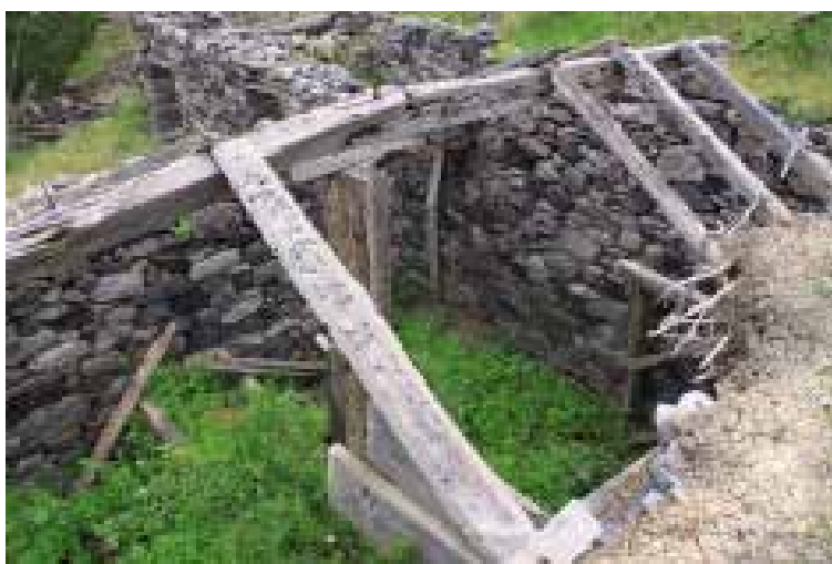
Ilustração 270 – Ruína. Composição da cobertura de salão. (Ilustração nossa, 2016).
