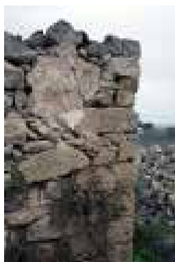
Ilustração 46 – Pormenor da parede exterior. (Ilustração nossa, 2016).
