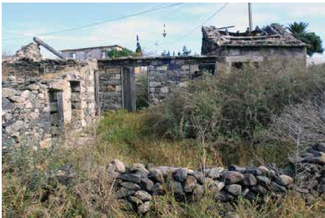
Ilustração 178 – Vista Oeste da área edificada. (Ilustração nossa, 2016).
