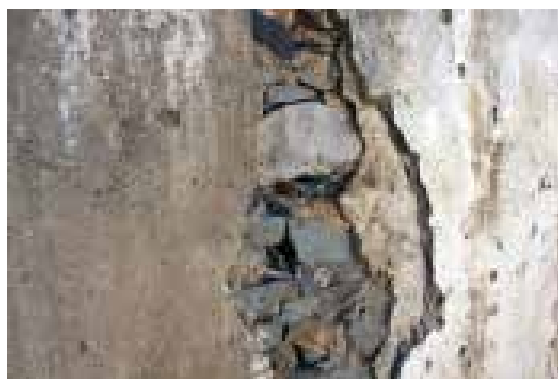
Ilustração 169 – Parede exterior vista pelo interior da habitação. (Ilustração nossa, 2016).
