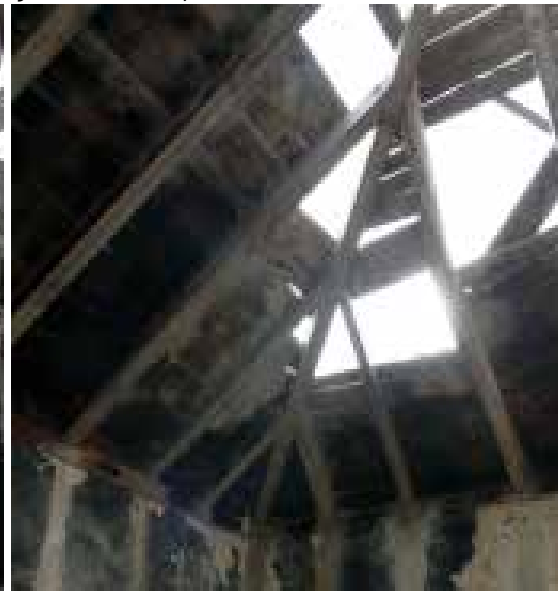
Ilustração 94 - Armação do rincão da cobertura no interior da habitação. (Ilustração nossa, 2016).
