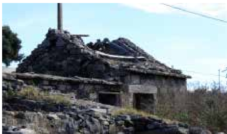
Ilustração 177 – Vista do alçado Oeste do conjunto edificado. (Ilustração nossa, 2016).
