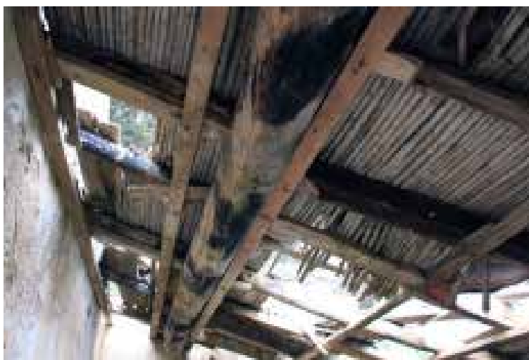
Ilustração 53 – Cobertura com forro de canaveira. (Ilustração nossa, 2016).
