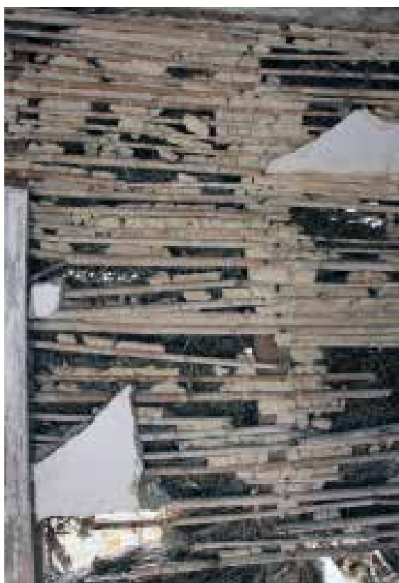
Ilustração 64 – Pormenor da parede divisória. (Ilustração nossa, 2016).
