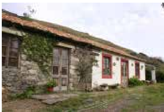
Ilustração 243 – Edificação. (Ilustração nossa, 2016).
