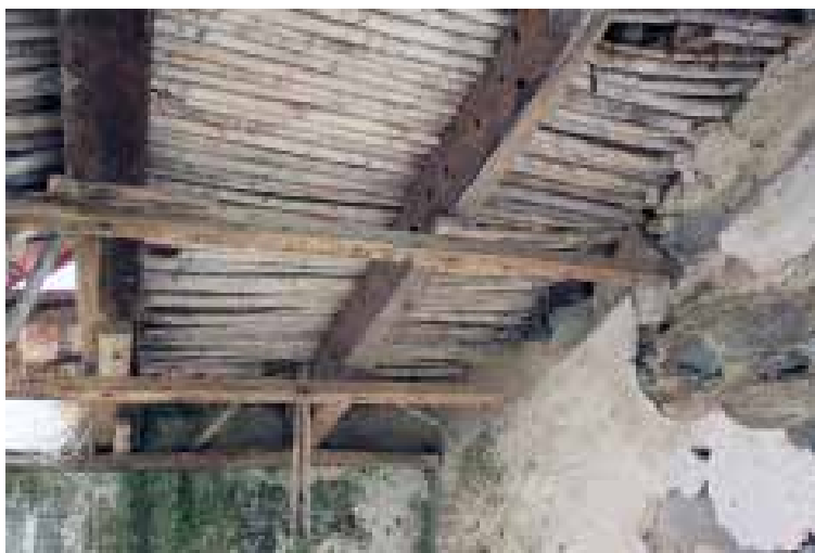
Ilustração 194 – Vista interior da cobertura de salão com canaveira e telha. (Ilustração nossa, 2016).
