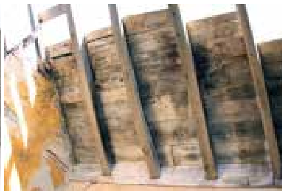
Ilustração 136 – Pormenor dos caibros e ripas de madeira da cobertura da casa de salão. (Ilustração nossa, 2016).
