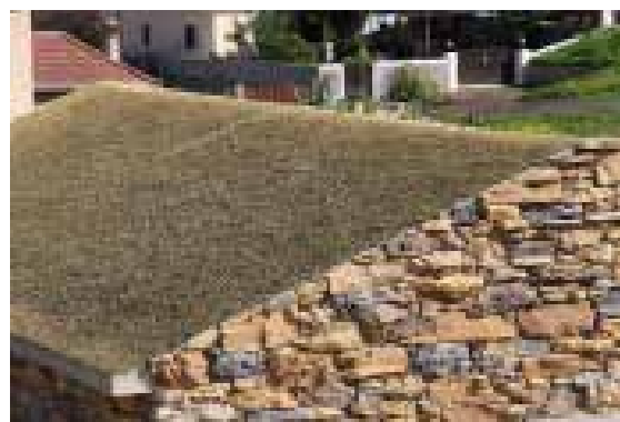
Ilustração 247 – Cobertura de betão idêntica à de salão. (Ilustração nossa, 2016).
