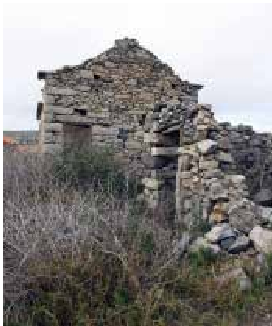
Ilustração 120 – Fachada Este do palheiro e estábulo, e ruína de pequeno estábulo. (Ilustração nossa, 2016).
