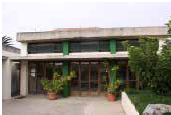
Ilustração 237 – Fachada da escola primária. (Ilustração nossa, 2016).
