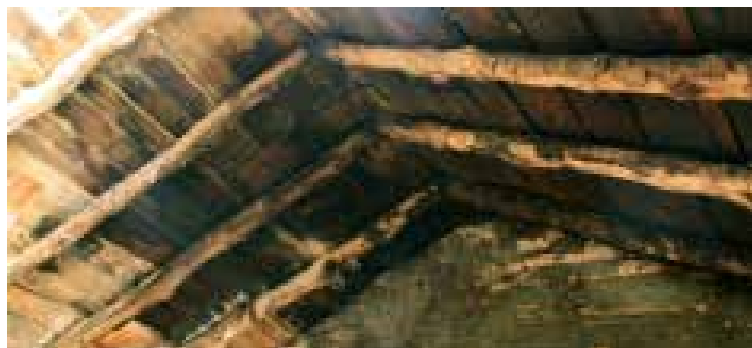
Ilustração 188 – Vista interior da cobertura de salão com telha. (Ilustração nossa, 2016).
