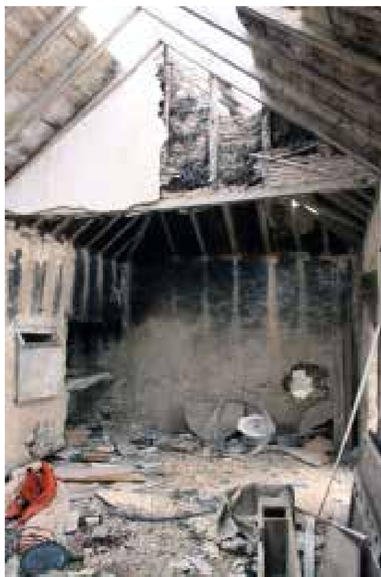
Ilustração 105 – Cozinha da casa de salão. (Ilustração nossa, 2016).
