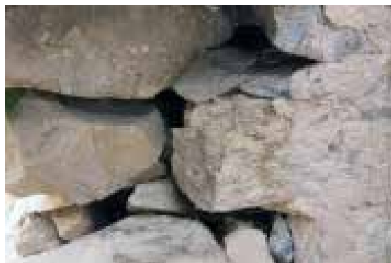
Ilustração 92 – Pedra calcária aparelhada da parede exterior da casa de salão. (Ilustração nossa, 2016).
