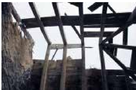
Ilustração 95 – Cobertura da casa de salão vista interior – caibros de madeira. (Ilustração nossa, 2016).
