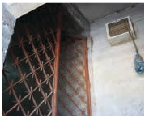
Ilustração 135 – Grade metálica na rua interior. (Ilustração nossa, 2015)
