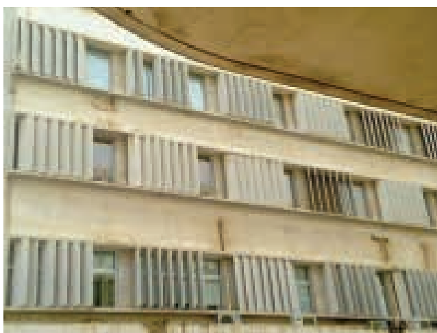
Ilustração 52 – Elementos rotativos de protecção solar de um edifício situado na marginal. (Ilustração nossa, 2015)
