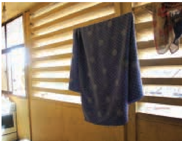
Ilustração 115 – Grelha laminada em betão na varanda da cozinha e zona de lavagens. (Ilustração nossa, 2015)
