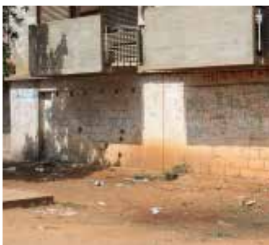
Ilustração 180 – Encerramento do espaço das garagens com bloco de cimento na fachada Norte. (Ilustração nossa, 2015)
