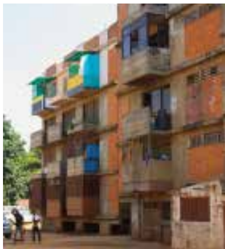
Ilustração 176 – Varandas transformadas em marquises. (Ilustração nossa, 2015)
