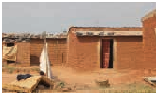
Ilustração 42 – Utilização do adobe como material de construção numa habitação na cidade de Menongue pertencente à província do Cuando-Cubango. (Mendes, 2015a)
