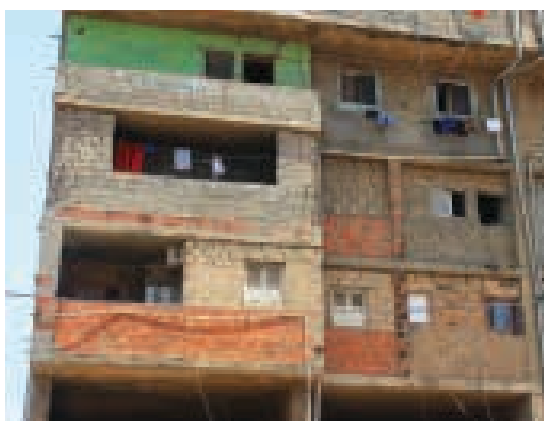
Ilustração 129 – Construção informal num edifício inacabado. (Ilustração nossa, 2015)
