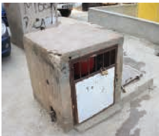
Ilustração 132 – Bomba e depósito de água. (Ilustração nossa, 2015)
