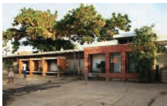
Ilustração 60 – Estado actual do edifício-muro do Cine-Miramar. (Ilustração nossa, 2014)
