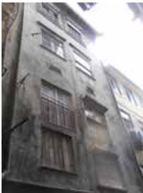
Ilustração 100 - Fachada da Rua dos Mercadores antes da intervenção – Operação C (Projecto 3) (PORTO VIVO, SRU, 2015)
