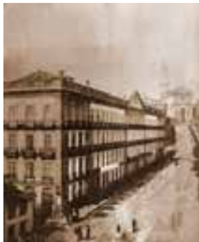
Ilustração 31 - Fachada do Palácio das Cardosas (SOCIEDADE SECRETA DE REABILITAÇÃO URBANA, 2015)
