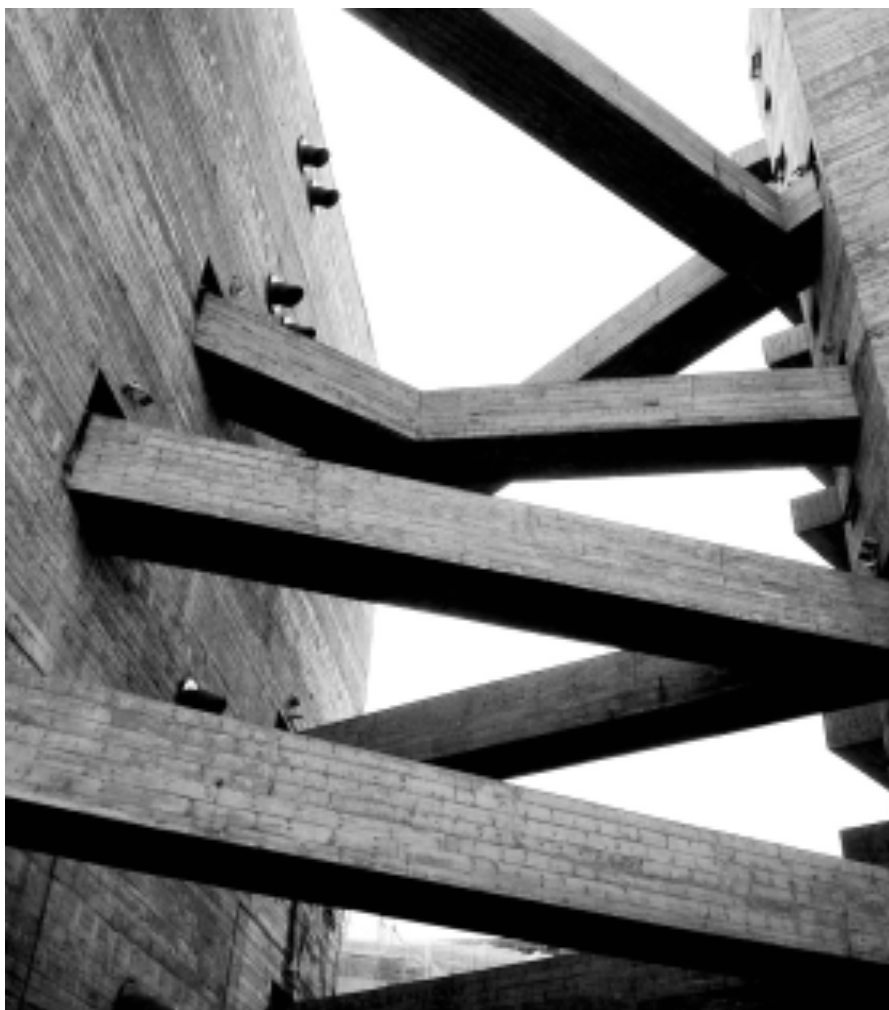
Ilustração 67 – Pormenor dos acessos em ponte do Complexo Desportivo do Sesc Pompéia (São Paulo, Brasil), projeto da Arqta. Lina Bo Bardi. (Giovani Comin, 2007)
