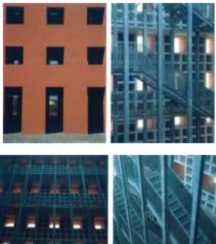
**Ilustração 134** – Nichos na espessura da parede, escadas apoiadas numa estrutura de aço. (Arnell, Bickford, 1985, p. 101)
