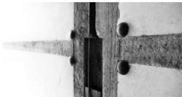
Ilustração 106 – Detalhe com rebites. (Polano, 1995, p. 98)
